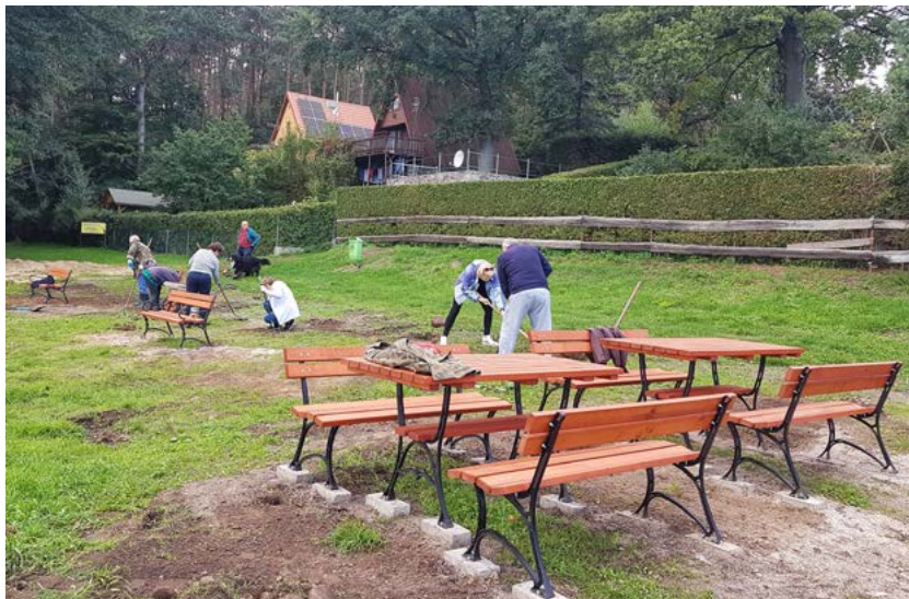
Prace nad modernizacją terenu, źródło: archiwum realizatora projektu.
